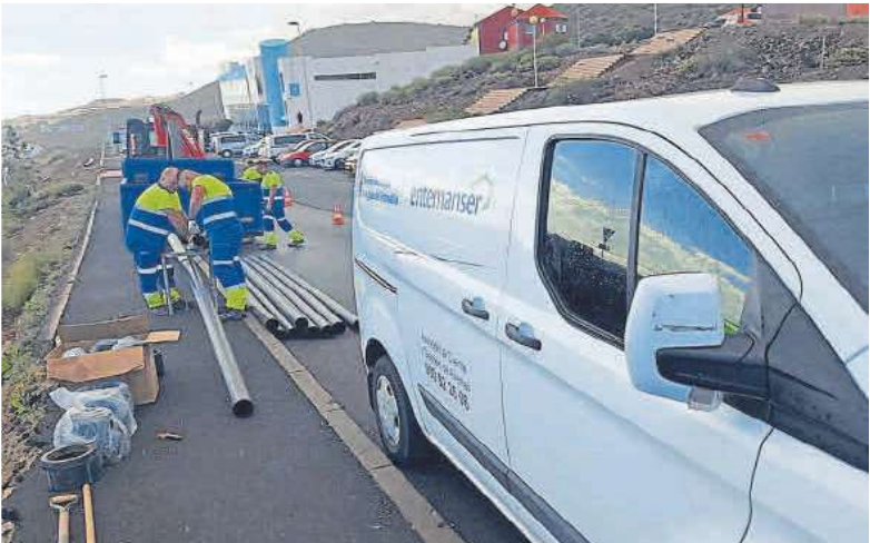
Operarios de Entemanser trabajan en la calle Hermanos Álvarez Quintero, ayer.
